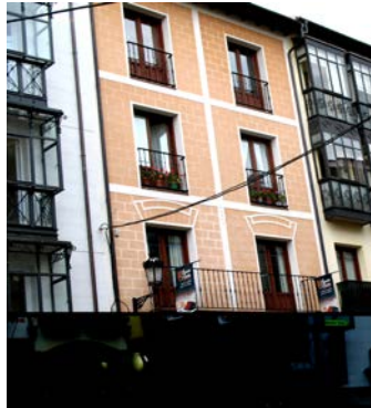
Edificio de oficinas en el Collado. F. autora 2006
