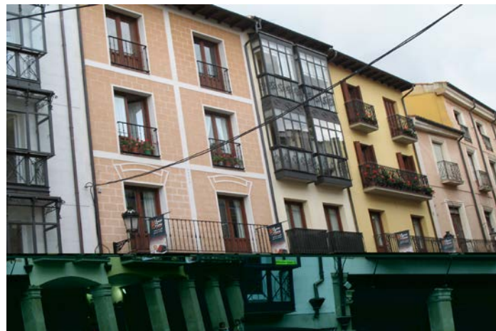
Edificios reconstruidos en el Collado. Mantienen la altura de la edificación previa y la anchura de la parcela histórica (F. autora 2006)
