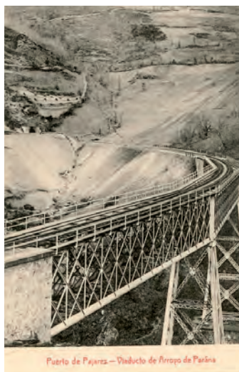
Figura 18. Viaducto de Parana, proyectado en curva en la oficina de G. Eiffel, hoy aterrado, y por el que bajó la excursión de Sela en 1883. Foto: Colección Sauvanaud, 1884, BNE
