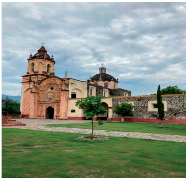
Fig. 6. Fachada Templo Concá que muestra la pintura de sillares en los contrafuertes para generar una visión de mayor dimensión.
