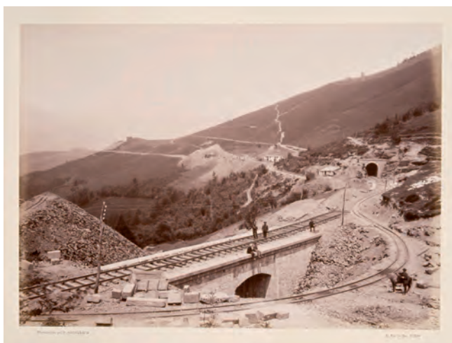
Figura 17. Estado de las cajas de la vía del ferrocarril y de servicio en 1984, por encima del pueblo de Pajares, en el tramo inferior del valle de Las Piedras. Sobre el puente posa una pareja de la guardia civil y descansan unos operarios.
