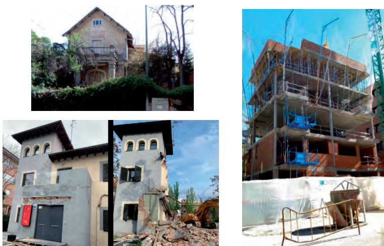
Figura 20. Deterioro y sustitución de Villa Virma en 2019 y demolición de una villa en López de Hoyos esquina a Arturo Soria en 2021
