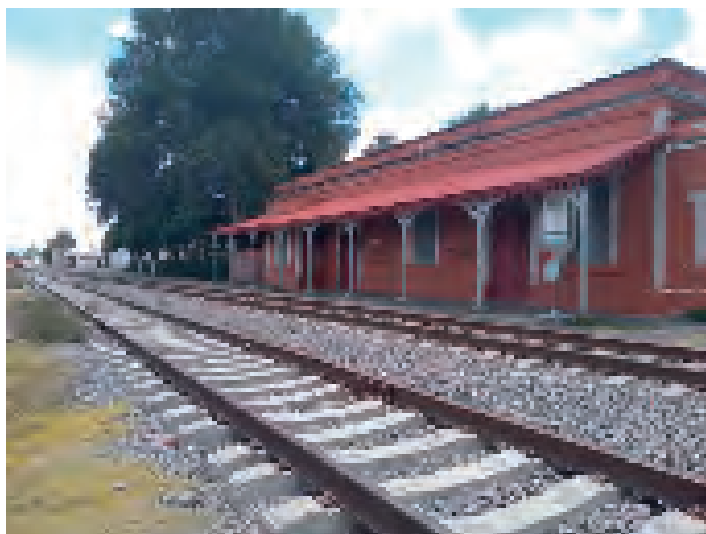
Figura 12. Estación de tren en Apan, Hidalgo. Larrucea, 2021.
