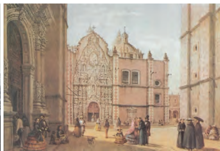
Figura 3. Sector norte del atrio de la Iglesia de San Francisco en 1860, estampa de Casimiro Castro. Escena costumbrista desde la calle Plateros, hoy Madero: a la izquierda la capilla de Anánzazu, al fondo la portada de la capilla de Balvanera y a la derecha la capilla del Tercer Orden. Fuente: colección particular, Luis Felipe Cabrales.
