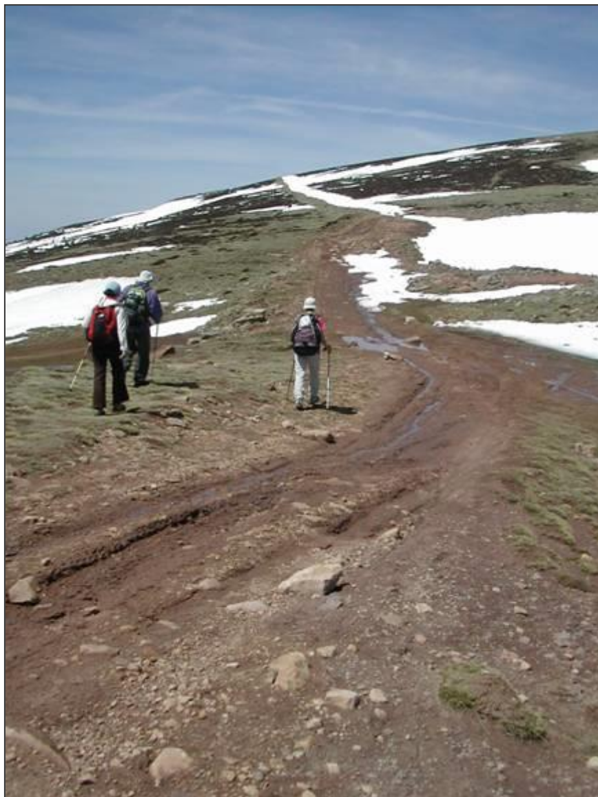
Ilustración 22. Procesos de erosión sobre la pista forestal que conduce al pico de Urbión
