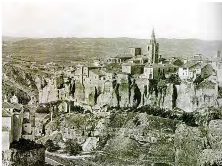
Fig. 11. Vista de la ciudad alta desde la hoz del Huécar, antes del derribo del puente de San Pablo y de la torre del Giraldillo o de las Campanas. (Hauser y Menet, 1892)
