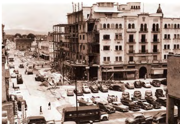
Figura 11. Transición paisajística en pleno proceso. En la construcción del edificio Lutecia, en 1939, se consideró un alineamiento que permitiera dejar un ancho de aproximadamente 20 metros en la calle Juárez (Sánchez, 2008: 25) aunque fue necesario un retranqueo adicional de 3,90 metros en el año 1948, una vez emprendidas las tareas de ensanchamiento. Sobre el eje se observa el edificio telefónico todavía sin alinear. Fuente: Colección particular, Luis Felipe Cabrales.
