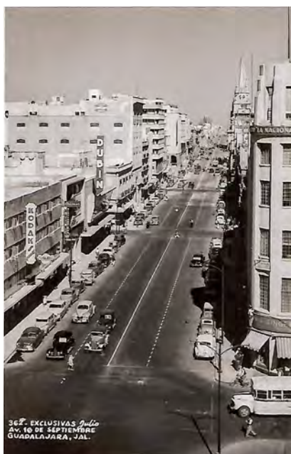
Figura 6. El primer plano muestra el trazo de la antigua calle San Francisco, la cual desarrolló una especialización comercial derivada de su contacto con la estación del Ferrocarril inaugurada en 1888. El eje Alcalde – 16 de Septiembre ya ensanchado exhibe la renovación edilicia y la reestructuración del comercio. Al fondo del lado derecho se percibe la Catedral. Fuente: Colección particular, Luis Felipe Cabrales.
