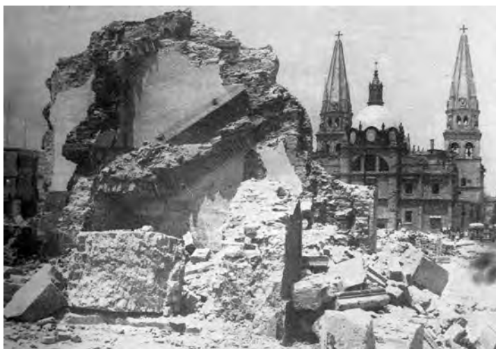
Figura 1. Demolición de fincas patrimoniales del par de manzanas situadas en la parte trasera de la Catedral. En 1952 se inauguró sobre dicha superficie la Plaza de la Liberación, obra emblemática de las operaciones de reforma emprendidas durante el mandato del Gobernador Jesús González Gallo. Fuente: Departamento Cultural del Estado (1953: s/p).
