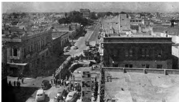
Figura 9. Imagen de la Avenida Juárez ensanchada a 25 metros y del desplazamiento del edificio de la Compañía Telefónica y Telegráfica Mexicana, labor realizada entre el 24 y el 28 de octubre de 1950. Sobre el frente no rebanado se percibe el dominio de fincas históricas y resalta por su verticalidad el “Edificio Profesional” construido por el ingeniero Jorge Matute Remus en 1947. Fuente: Departamento Cultural del Estado (1953: s/p).
