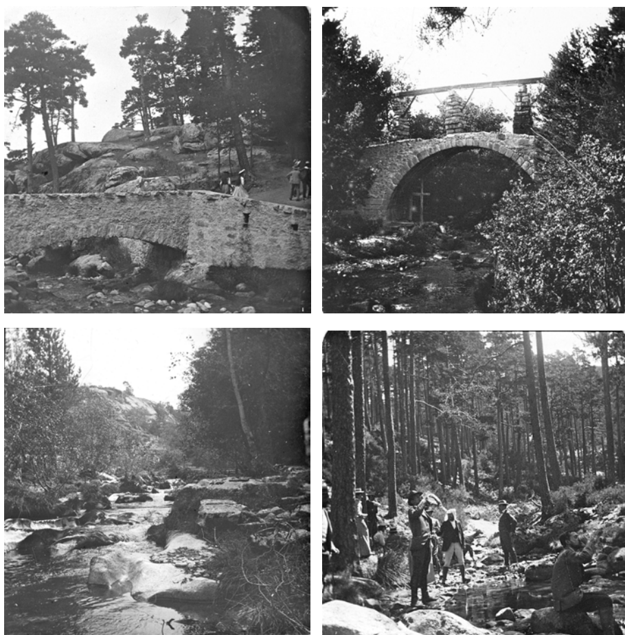
Figuras 15, 16, 17 y 18. Puente de la Boca del Asno (1900), puente de los Canales (1902), arroyo Valsain (h. 1900), y arroyo de la Chorranca (1899), en el Pinar de Valsain, Sierra de Guadarrama. Fotografías de Augusto Arcimís (Archivo Arcimís. Fundación Duques de Soria: IPCE).
