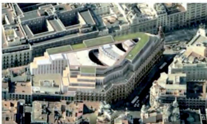
Estado final de los edificios englobados en la "Operación Canalejas", en una vista aérea incluida en el informe elaborado por el Estudio Lamela, donde se observa el injustificable recrecido en altura de los diversos inmuebles.
