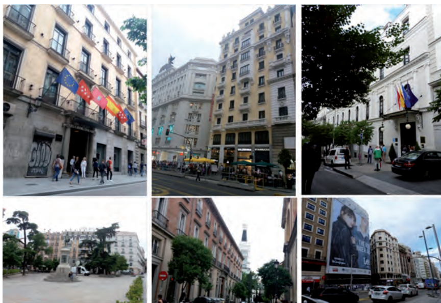
Fig.16. Rehabilitación y renovación de edificios singulares para destinarlos a hoteles. 1. Catalonia Puerta del Sol (Calle Atocha). 2. Petite Palace (Gran Vía) 3. Gran Meliá Palacio de los Duques (Cuesta de Santo Domingo). 4. Villamagna (plaza de las Cortes). 5. N.H. Collection, Palacio de Tepa (San Sebastián). 6. Futuro hotel Rex, de Room Mate Hotels (Gran Vía).
