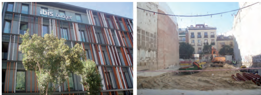
Figura 18. Hotel Ibis Budget y Hostel en construcción
