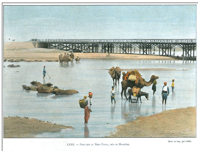
Figure 5. «Pont sur le Yodu-Tohai», photographies de MM. Sébah et Joaillier frères, in Turquie, types et mœurs , fasc. 9, L. Boulanger.
