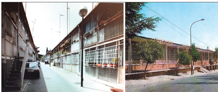
Figura 11. Continuidades y cambios. Imagen de una zona peatonal de la UVA con una fachada en la que observan las escaleras de acceso y algunas terrazas de la primera planta con cerramientos privados. A la derecha, fotografía de la Guardería Infantil. Los equipamientos originales de la UVA apenas han sido retratados.
