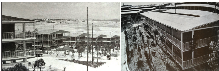
Figura 5. En construcción. A la izquierda, vista de los bloques en la calle Mar de las Antillas con las zonas ajardinadas en primer término. Se aprecia el desnivel de la zona y los terrenos sin urbanizar al norte de UVA de Hortaleza. A continuación, fotografía de los edificios residenciales del sector central. Firmada como “Fotos Gómez”.
