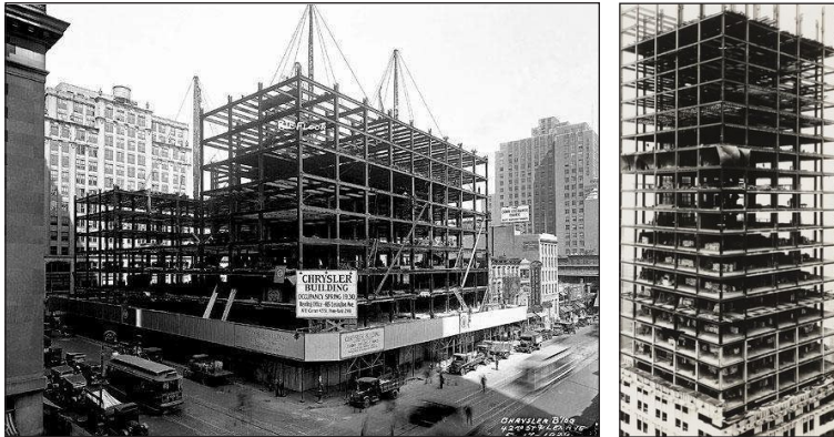
Figura 6. Walter Evans: construcción del Edificio Chrysler ( https://www.pinterest.com ).
