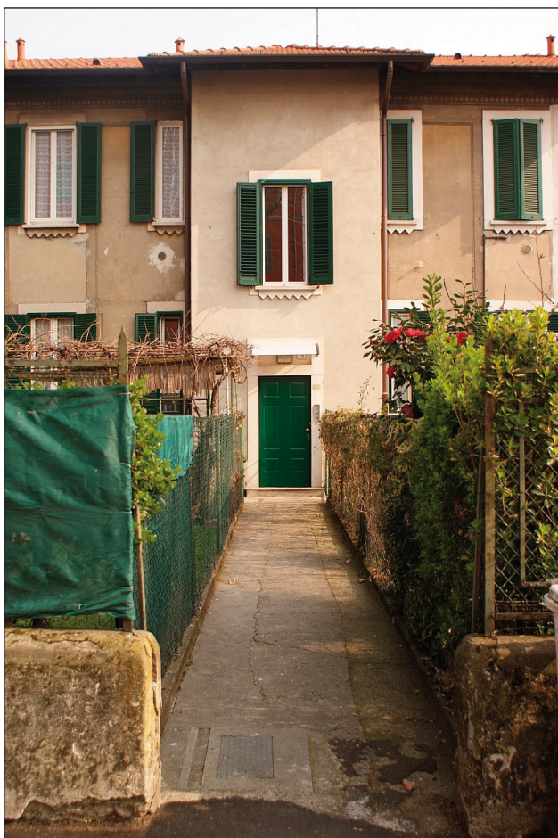
Fig. 1.- Ingresso di una delle abitazioni del Villaggio Falck. Il complesso, il cui progetto risale al 1908, è tuttora abitato.
